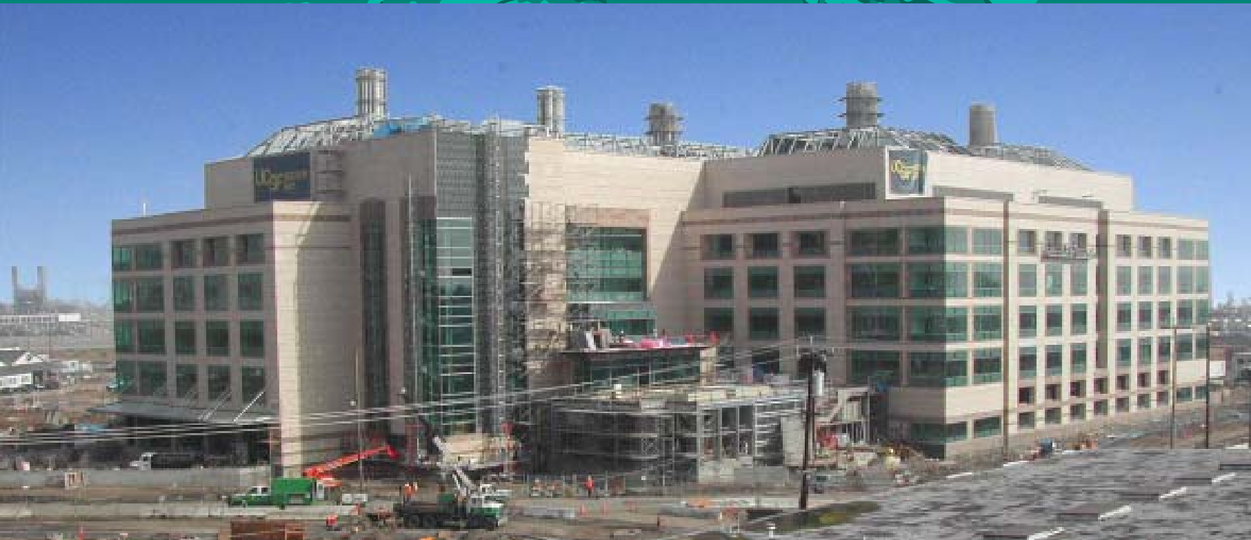
建設中のUCSFジェネンテック・ホール(第24ビル)
